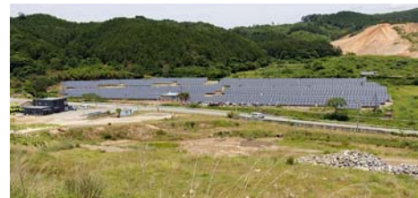
三重県鈴鹿大野太陽光発電設備構築工事
